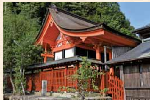
本殿は国の重要文化財
